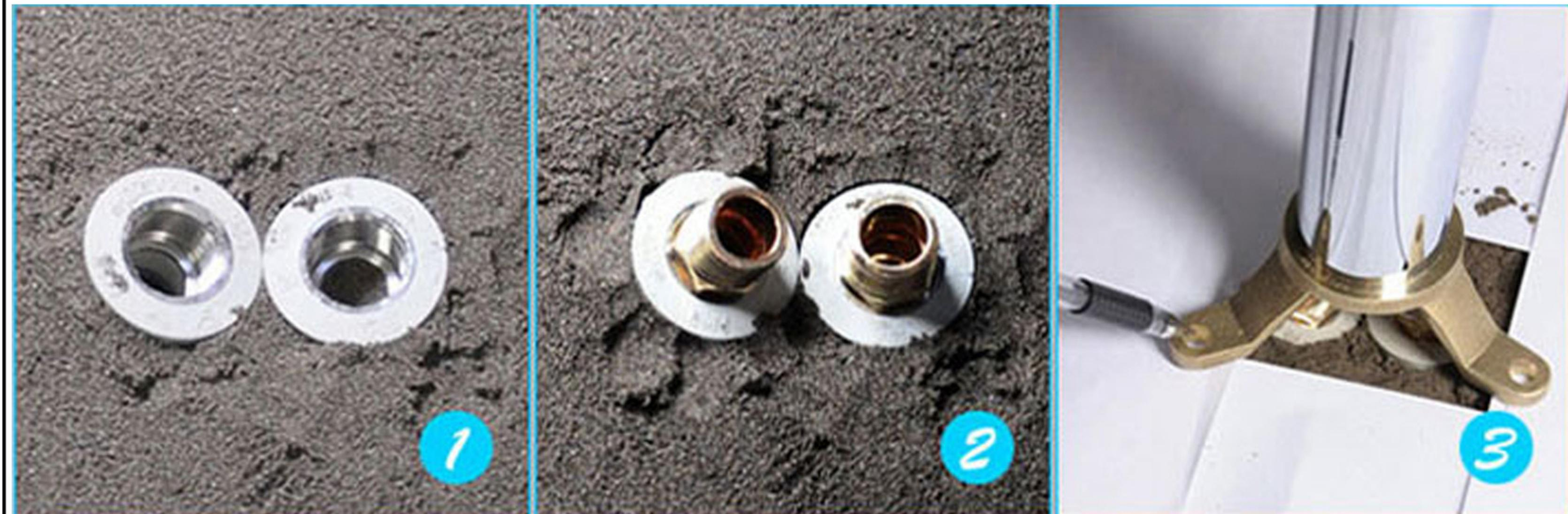
1.предварительно заглубленный соединитель для подвода воды, подвод горячей и холодной воды составляет около 15 градусов и находится на одном уровне с землей.
