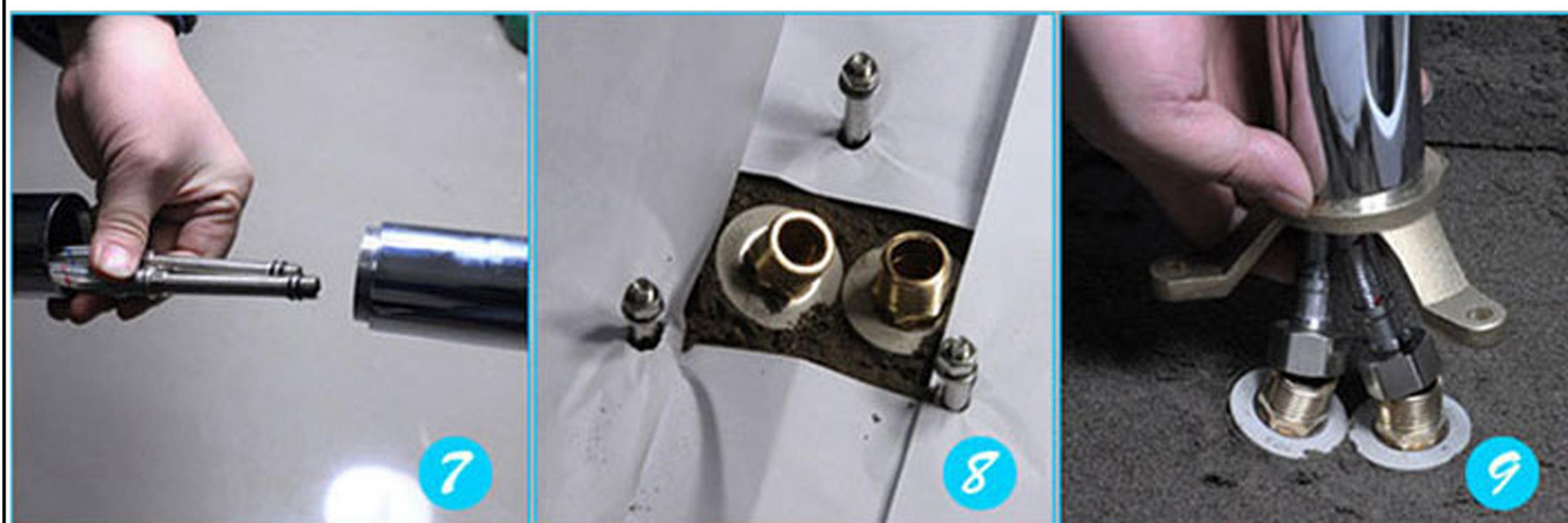
7.подсоедините основной корпус крана и затяните трубу высокого давления на входе крана
