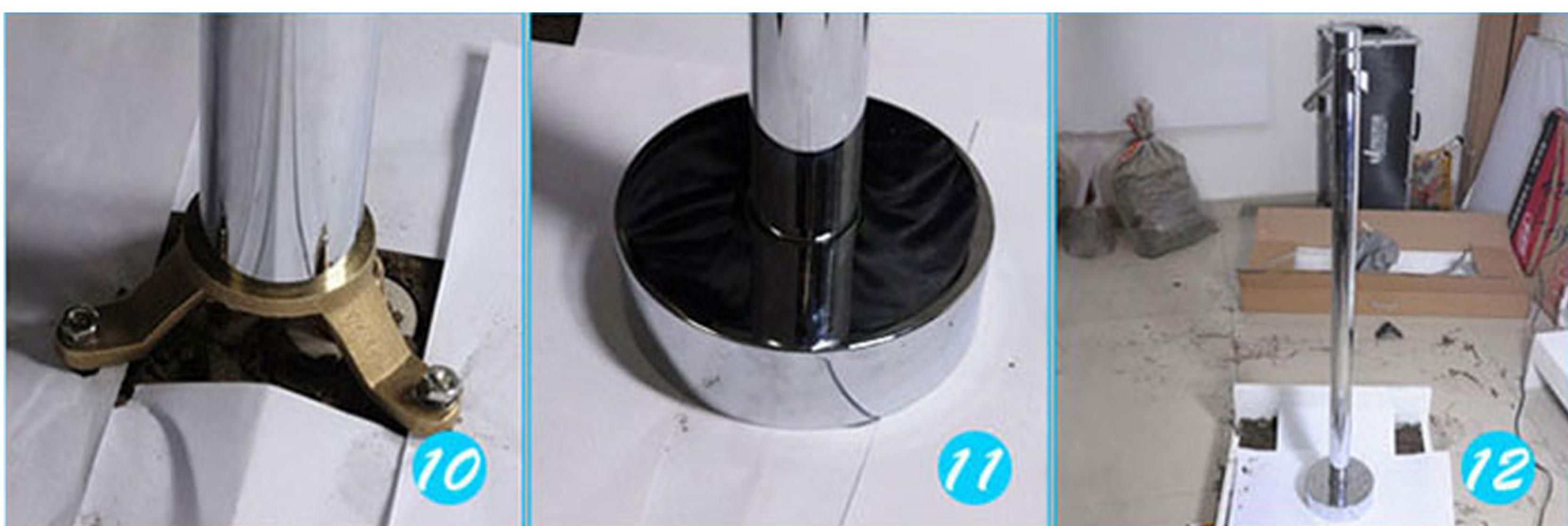
10.вставьте основной корпус крана в расширительный винт и затяните расширительный винт
